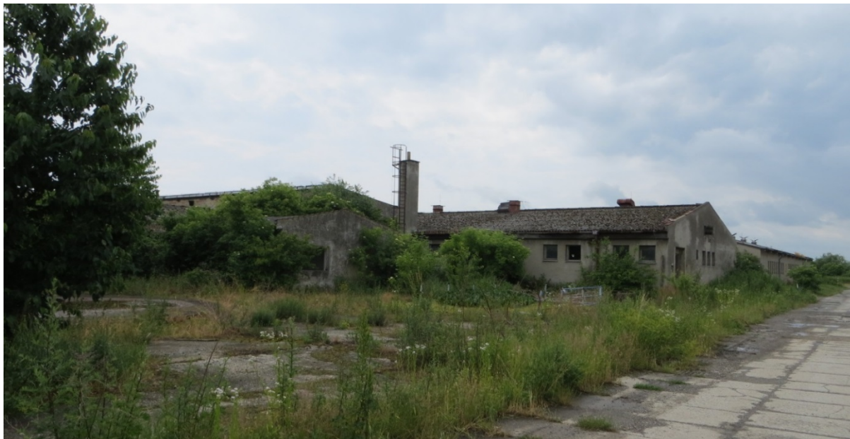
Obr. 11: Zdevastovaný areál bývalého vojenského statku ve Výmyslově
