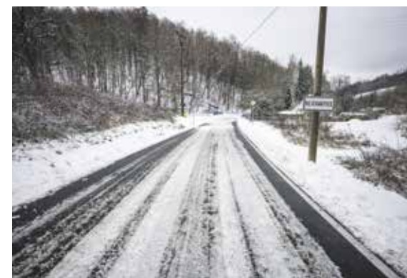
Rekonstrukce silnice na úseku Rapotín–Rejchartice přinesla pět kilometrů nové vozovky. Foto | Olomoucký kraj
