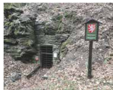
Zajištění vstupu do Soudkovy štol.
