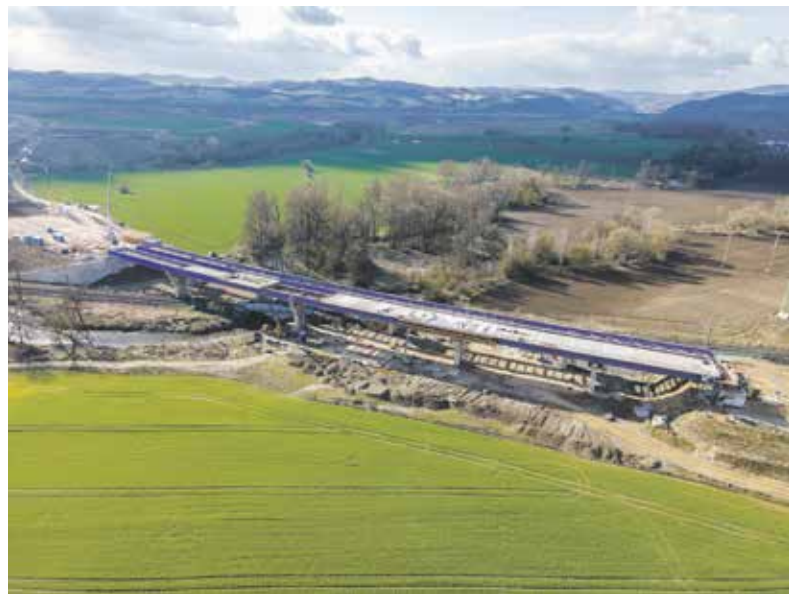
Obchvat Bludova – stavba mostu.
