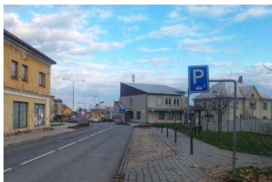
Obrázek 145: Parkovací odstavňový pruh u silnice
