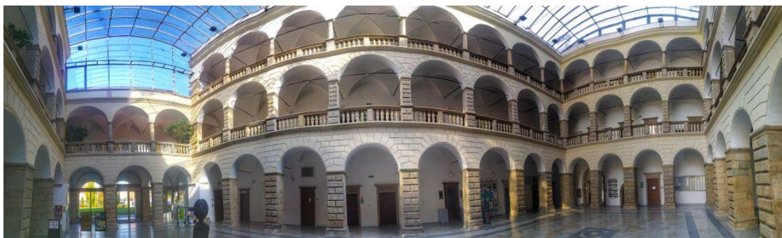
Obrázek 96: Panoramatický snímek rekonstruovaného nádvoří se zasklenou střechou
