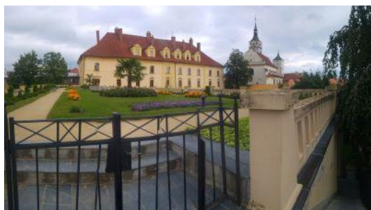
Obrázek 115: Písčité pěšiny na střešní zahradě
