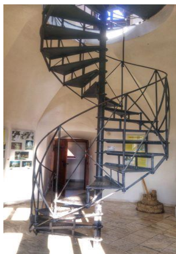
Obrázek 26: Točité kovové schodiště na vyhlídku na věži
