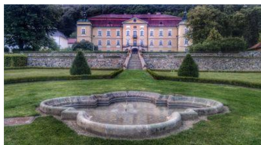
Obrázek 140: Do parčíku vede schodiště
