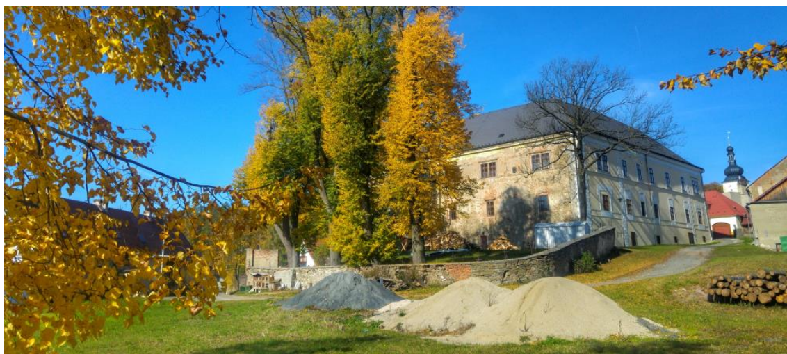
Obrázek 125: Exteriér zámku podléhá rekonstrukci fasády
