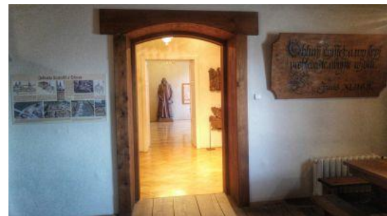
Obrázek 22: V prvním patře nejsou mezi průchody dveřmi umístěny prahy
