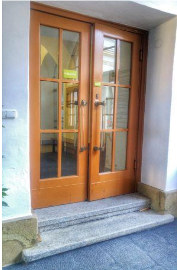
Obrázek 18: Vstup k pokladně vede přes dva schody
