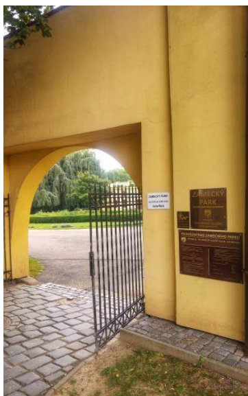
Obrázek 112: Dlažba na vstupu
