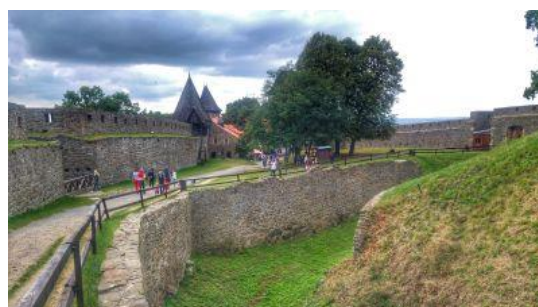
Obrázek 7: Hradní příkopy jsou opatřeny kovovými zábranami
