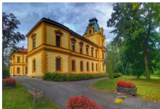
Obrázek 121: Asfaltový povrch v areálu
