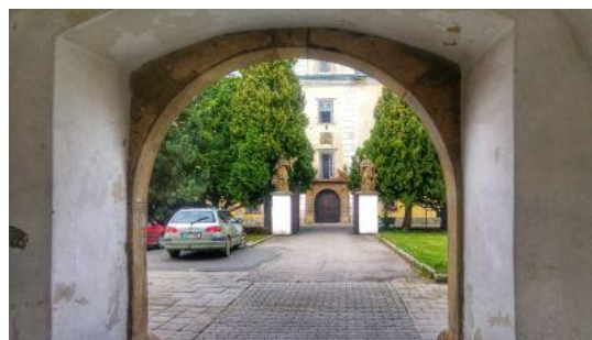
Obrázek 47: Vjezd do areálu je přes bránu
