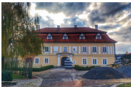
Obrázek 144: Přístup k zámku
