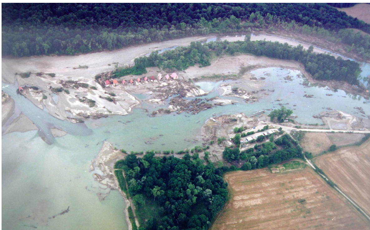
Obr. 2d: Fotodokumentace z povodně 07/1997 a protržení břehů Bečvy u Milotických jezer.
