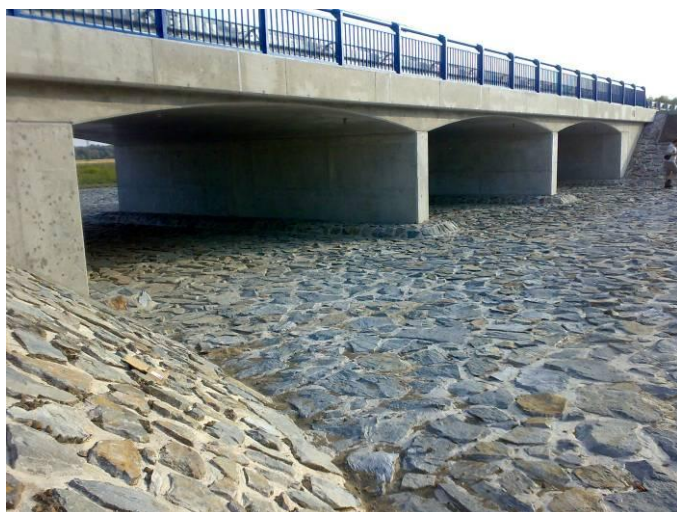
Foto 26: Silnice Mohelnice – Stavenice, jeden ze čtyř inundačních mostů
