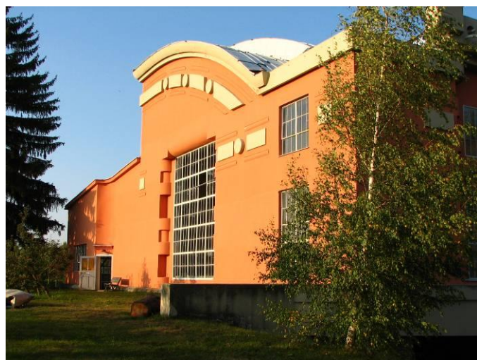
Foto 30: Osada Háj – národní kulturní památka Vodní elektrárna v Třeštině
