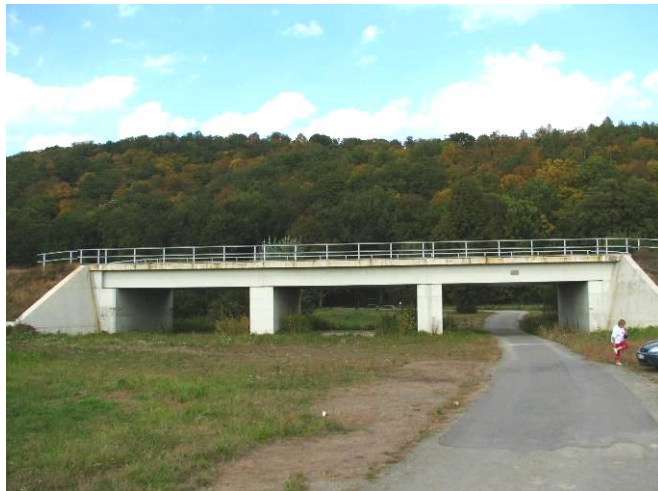
Foto 2: Nový inundační most na železnici Olomouc – Česká Třebová
