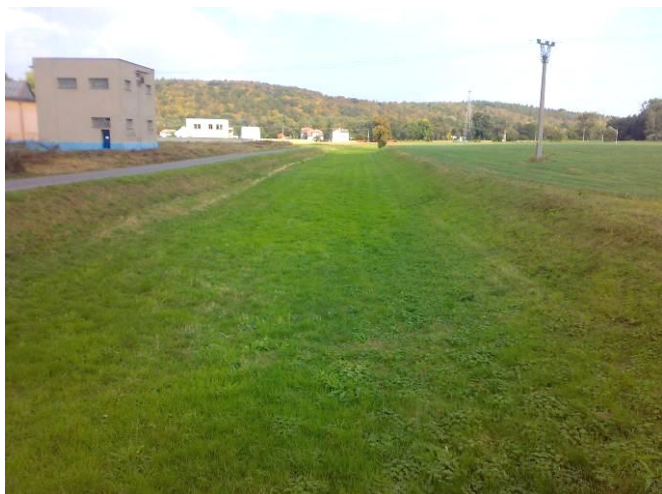
Foto 3: Odlehčovací koryto na Třebůvce kolem obce Moravičany
