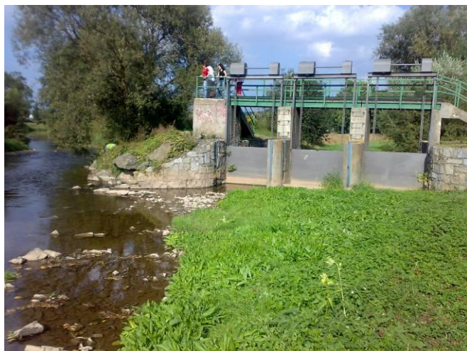
Foto 4: Hradící objekt na odlehčovacím rameni Třebůvky v Moravičanech
