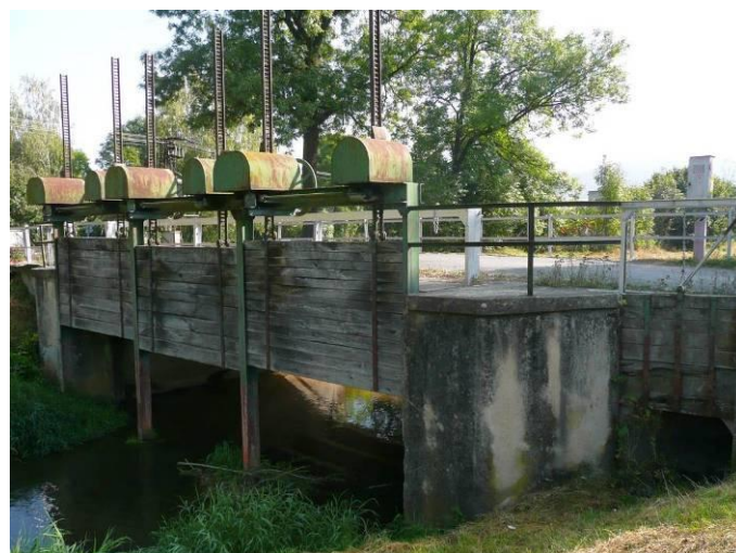
Foto 18: Vzdouvací zařízení na mostě na Třebůvce v obci Mezihoří s nátokem do melioračního kanálu
