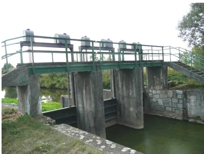
Foto 5: Hradící objekt na odlehčovacím rameni Třebůvky v Moravičanech
