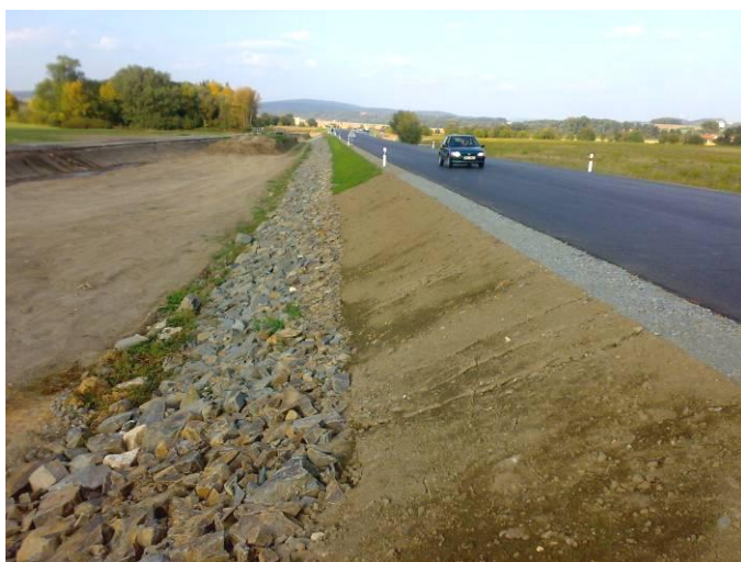
Foto 25: Nová silnice Mohelnice – Stavenice v profilu hráze SN Mohelnice
