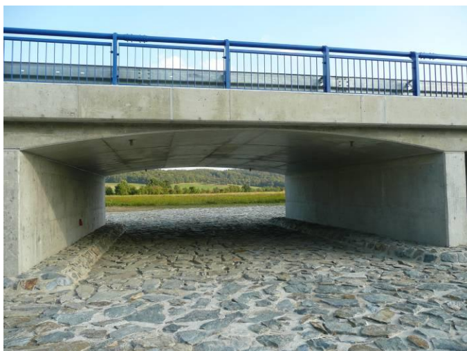
Foto 27: Detail pole inundačního mostu
