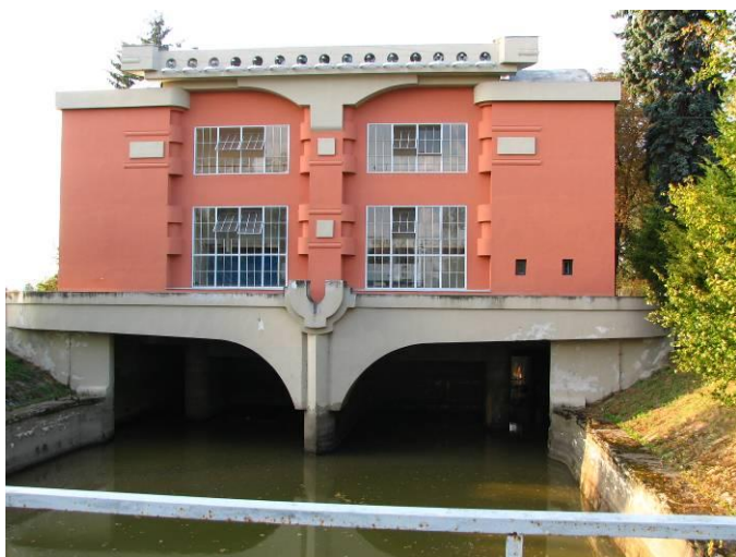
Foto 29: Osada Háj – národní kulturní památka Vodní elektrárna v Třeštině
