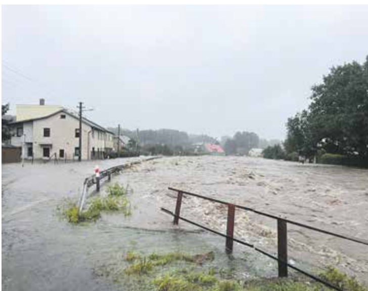
Desítky zničených kilometrů cest se postupně daří opravovat.
