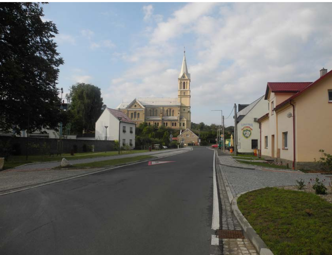
↑ Opravená ulice Hlavní, Mikulovice, září 2025, VMJ
