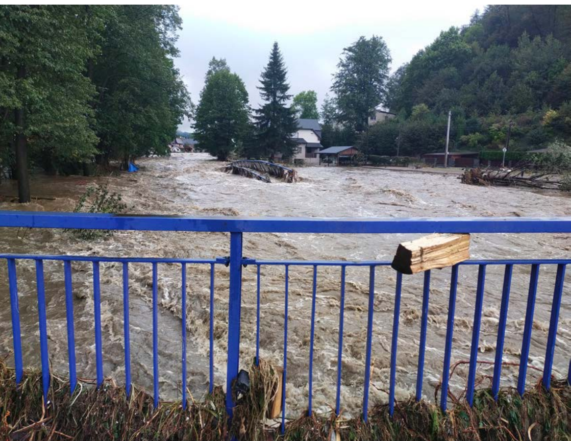
↑ Řeka Bělá pod mostem na ulici Rejvízská v Jeseníku krátce po opadnutí hlavní povodňové vlny. Zář 2024, VMJ
