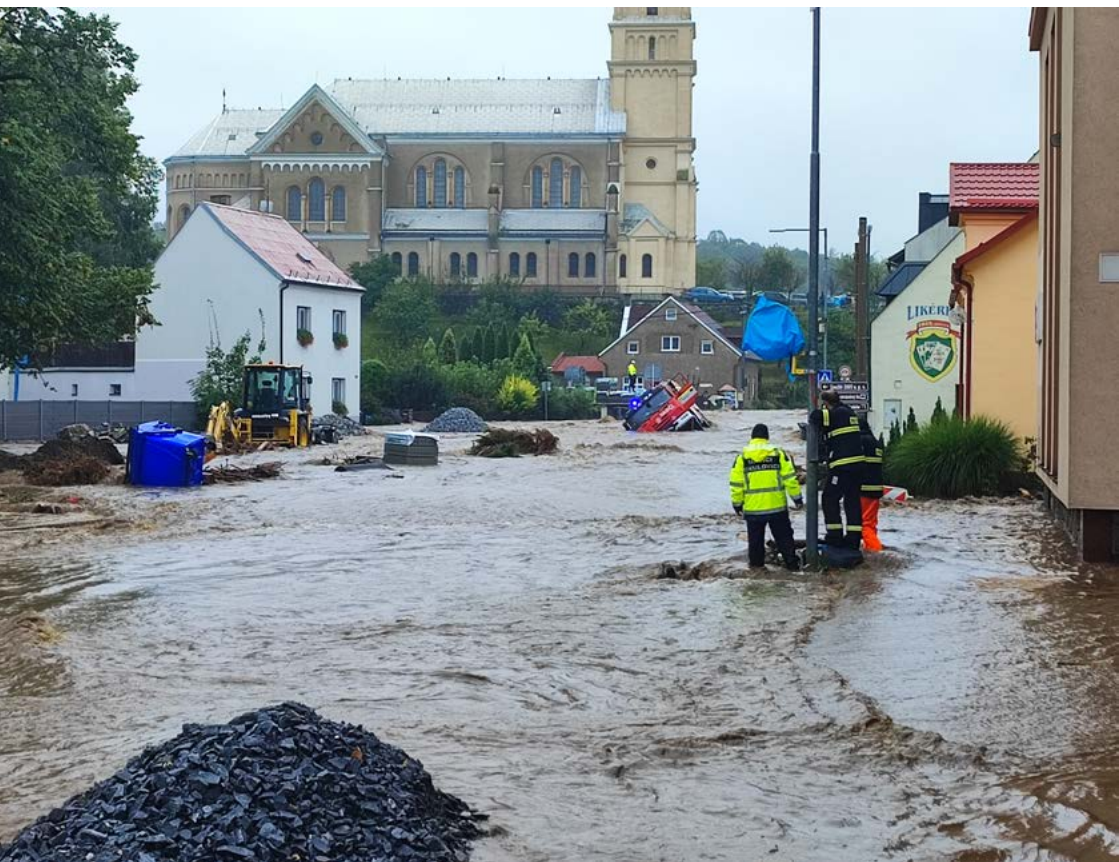
↑ Zaplavená ulice Hlavní v Mikulovicích u hranic s Polskem. Pohled na kostel sv. Mikuláše, září 2024, obec Mikulovice
