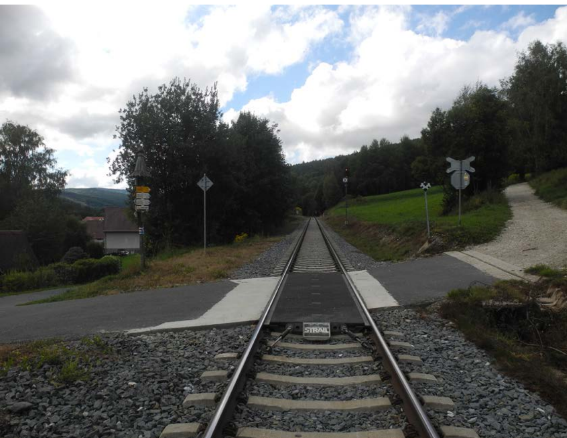
↑ Opravený přejezd, zprovozněná železnice, září 2025, Lipová-lázně, VMJ
