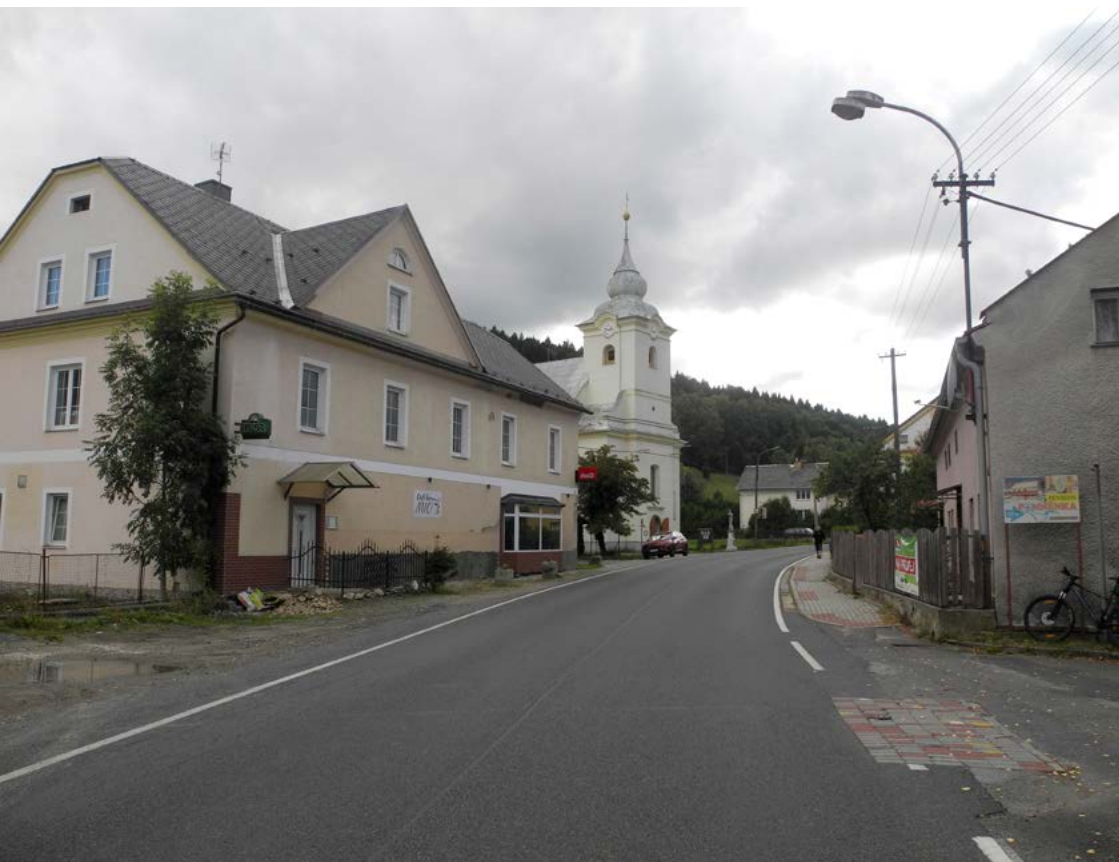
↑ Září 2025, opravená komunikace, Dolní Lipová v obci Lipová-lázně, VMJ
