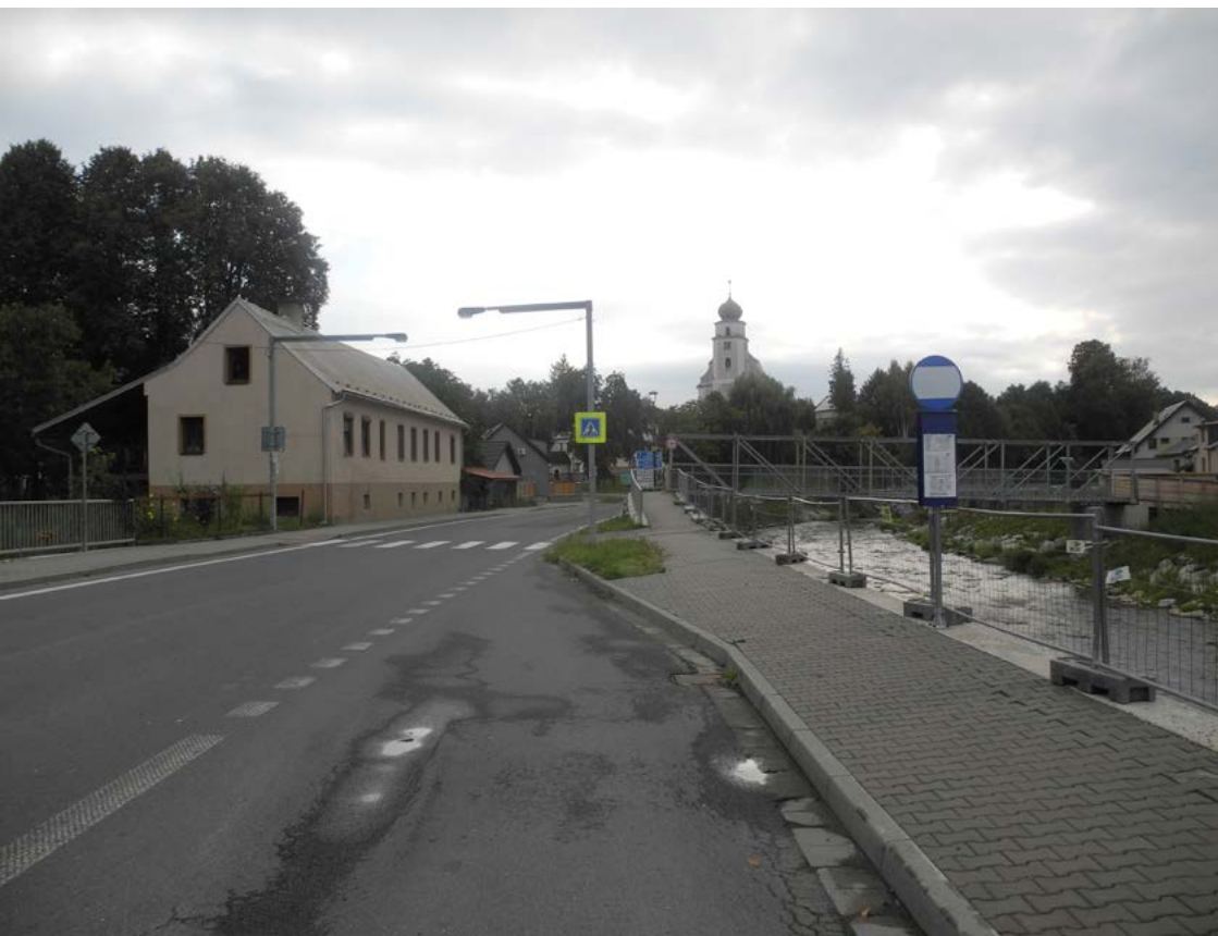
↑ Opravená komunikace, vybudované chodníky, září 2025, obec Písečná
