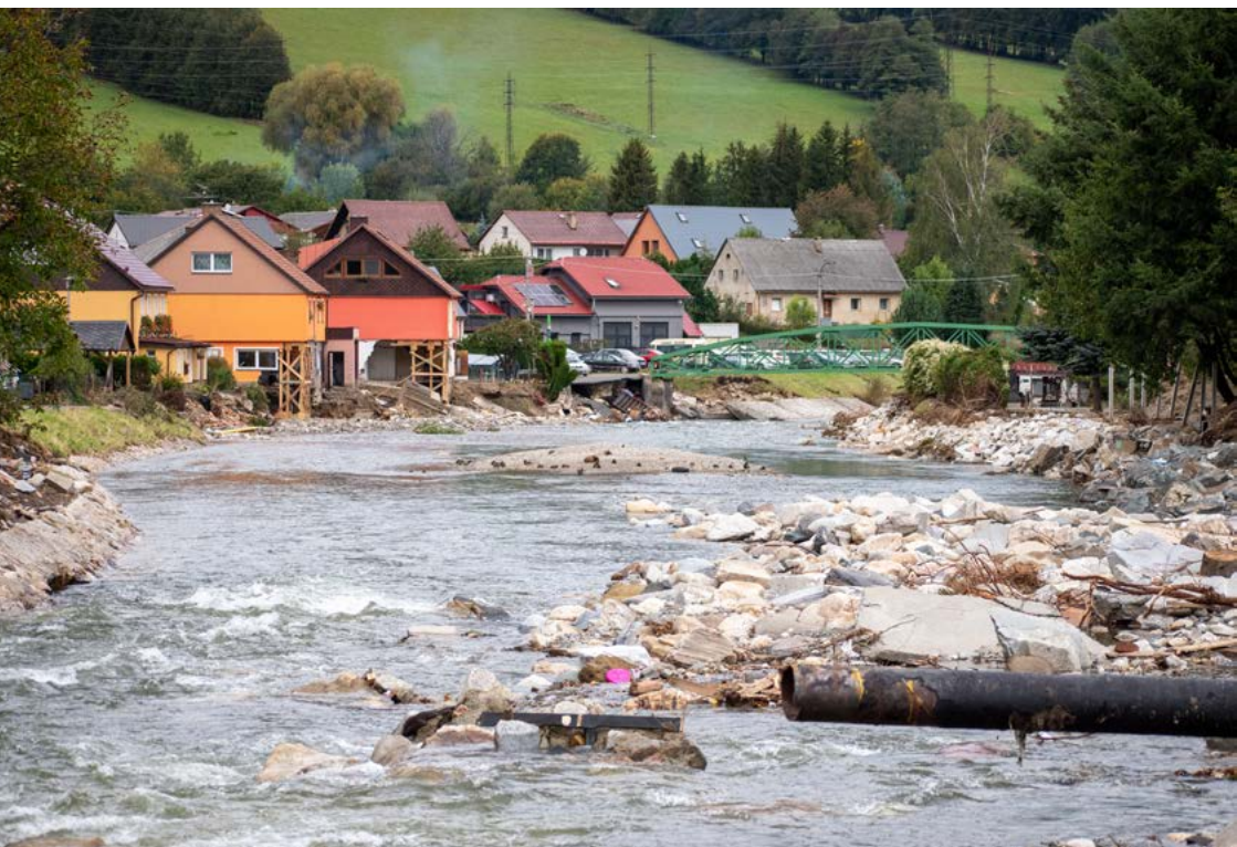
↑ Koryto řeky Bělé po opadnutí povodňové vlny, Česká Ves, září 2024, obec Česká Ves
