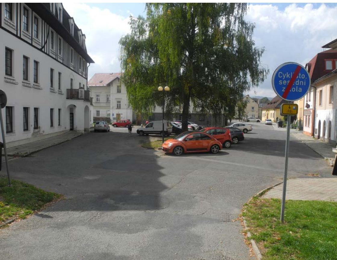
↑ Palackého ulice v Jeseníku – stav po opravách, září 2025, VMJ
