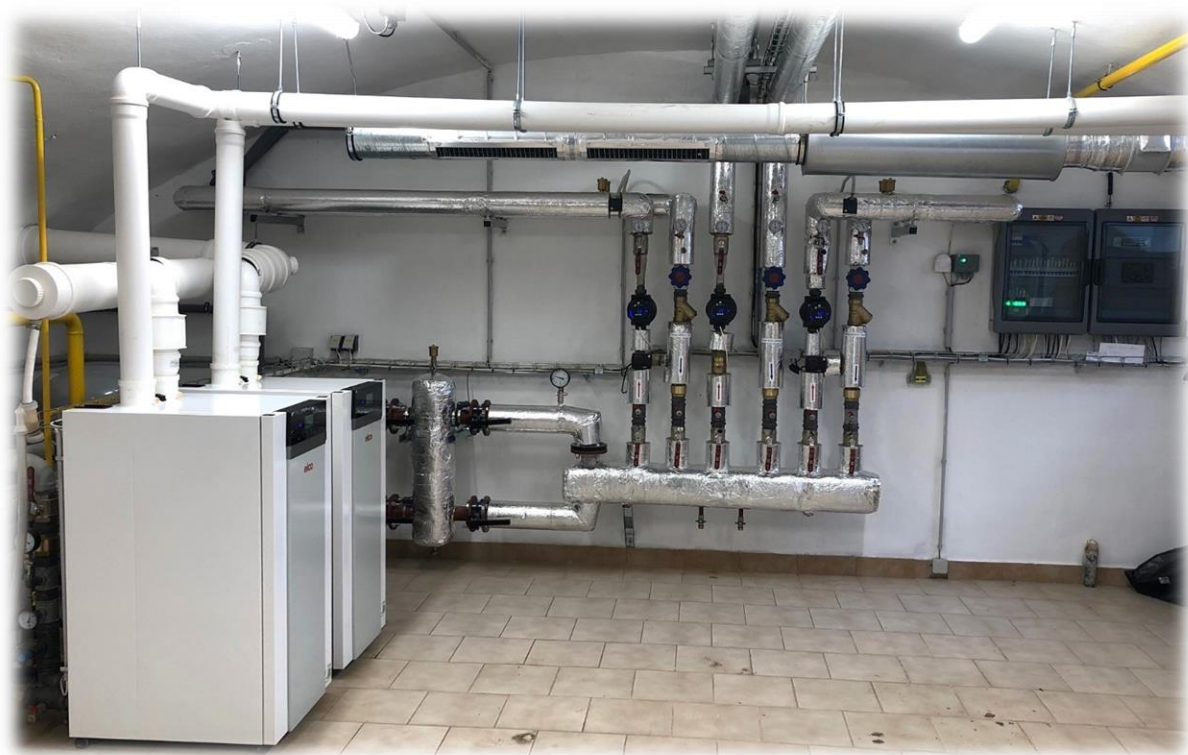
Kotelna v budově Zámek
