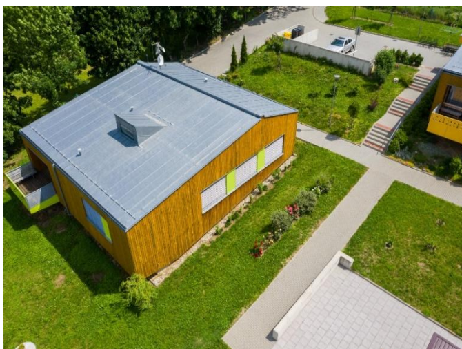
DZR Vincentinum Šternberk, Opavská 2631/34 a Opavská 2632/32
