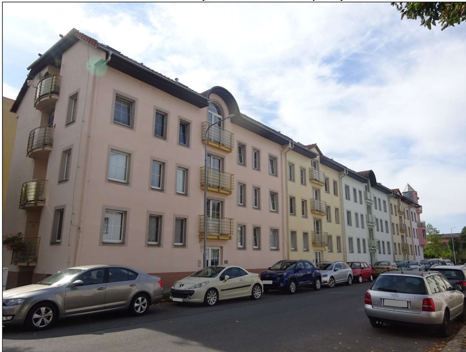
Obr. 15: Fotodokumentace zástavby v okolí kritického místa priority I v ulici Jiráskova
